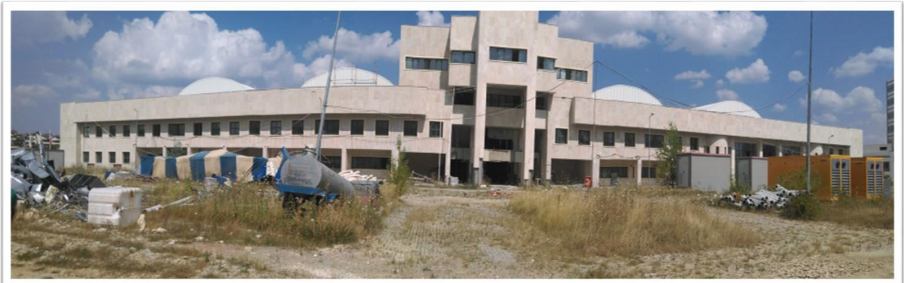
Resim 24: Kastamonu Tıp Fakültesi Hastane Binası
