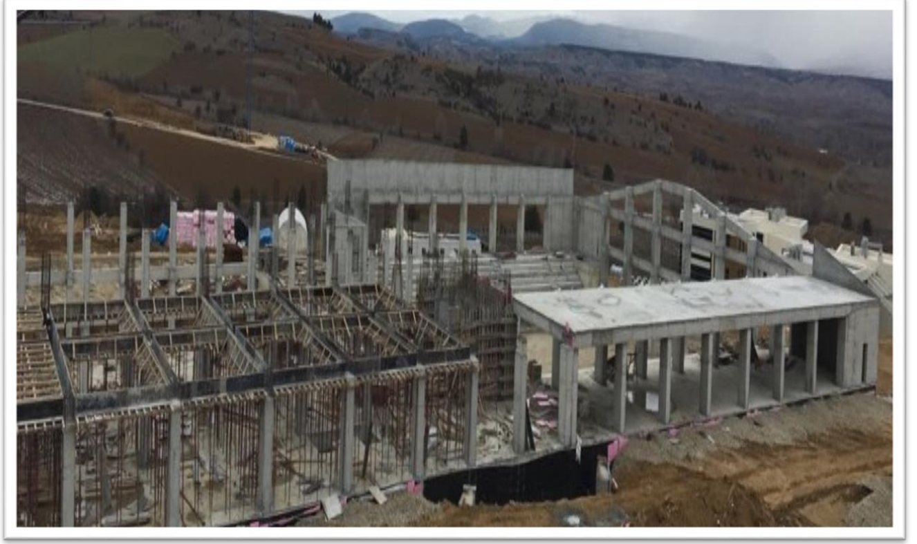
Resim 20: Spor Kompleksi İnşaatı
