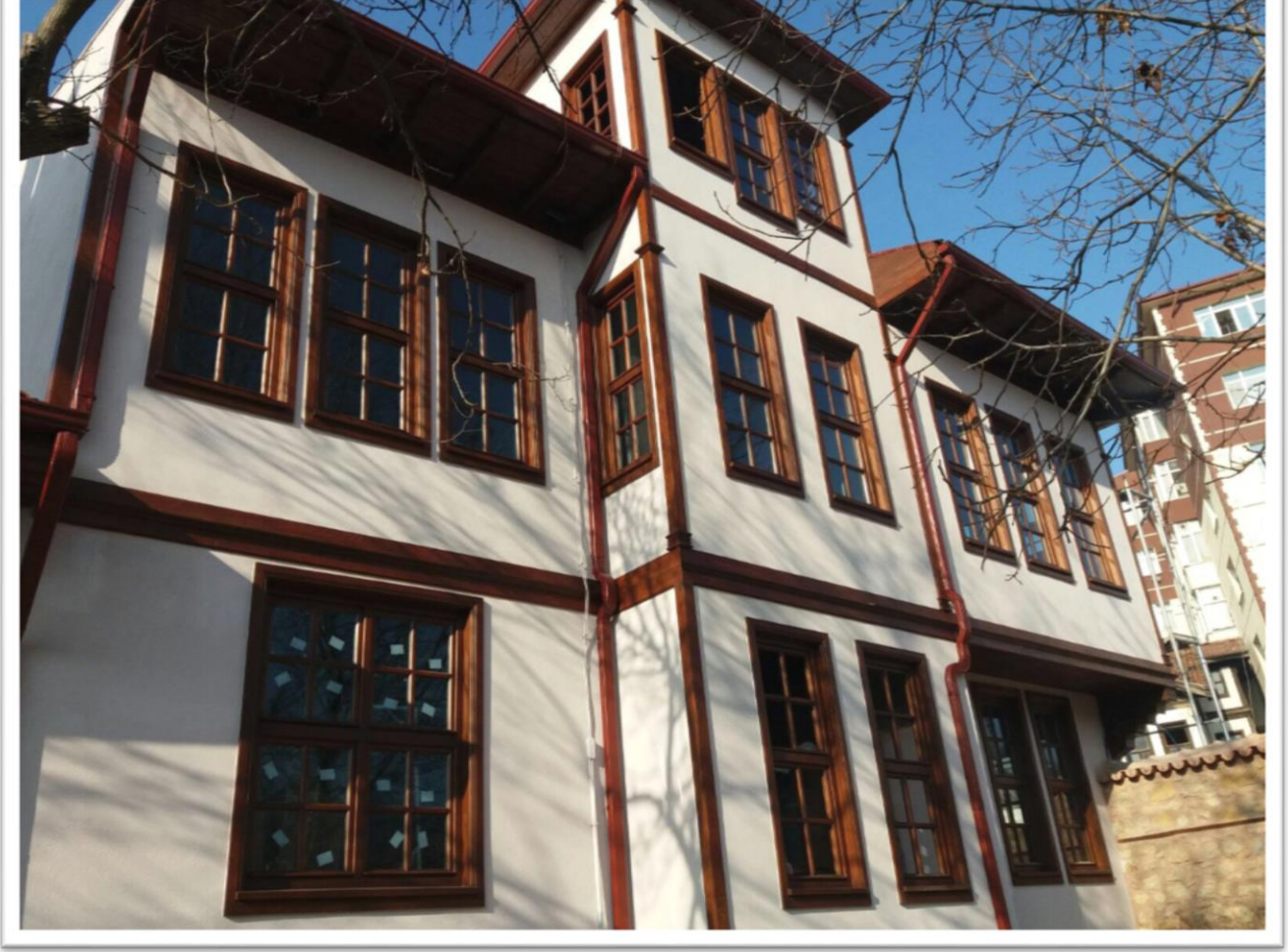
Resim 28: Yücebıyıklar Konağı Restorasyonu
