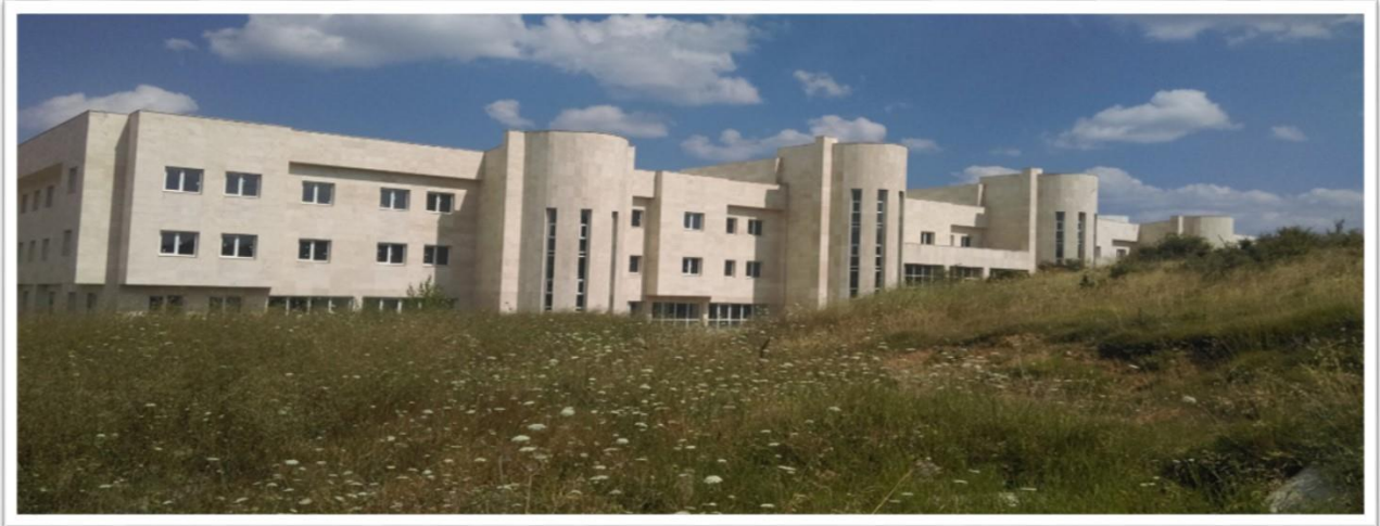
Resim 23: Kastamonu Tıp Fakültesi İlave Poliklinik Binası Arkadan Görünüş
