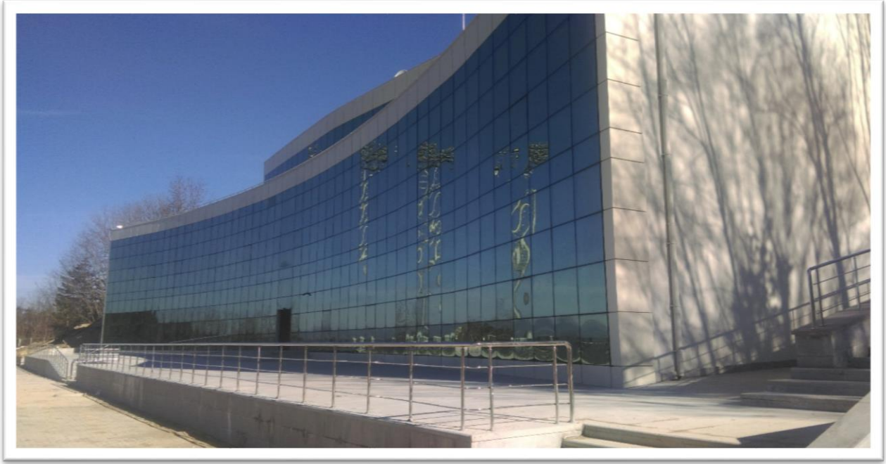
Resim: 6 Spor Tesisi İdari Hizmet Binası Önden Görünüş
