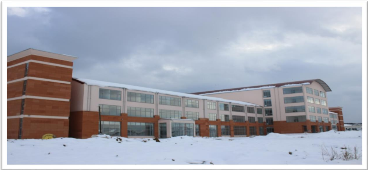
Resim:2 Sivil Havacılık Yüksekokulu Dıştan Görünüş
