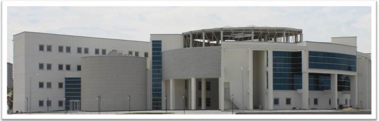
Resim:5 Rektörlük Binası Arka Görünüş
