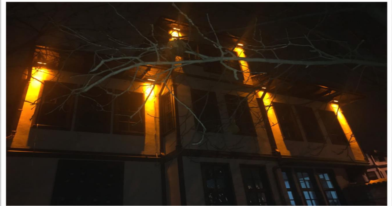
Resim 29: Yücebıyıklar Konağı Restorasyonu Gece Görünüşü
