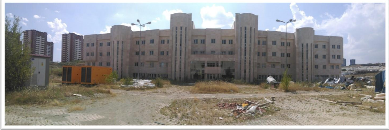
Resim 22: Kastamonu Tıp Fakültesi İlave Poliklinik Binası Önden Görünüş
