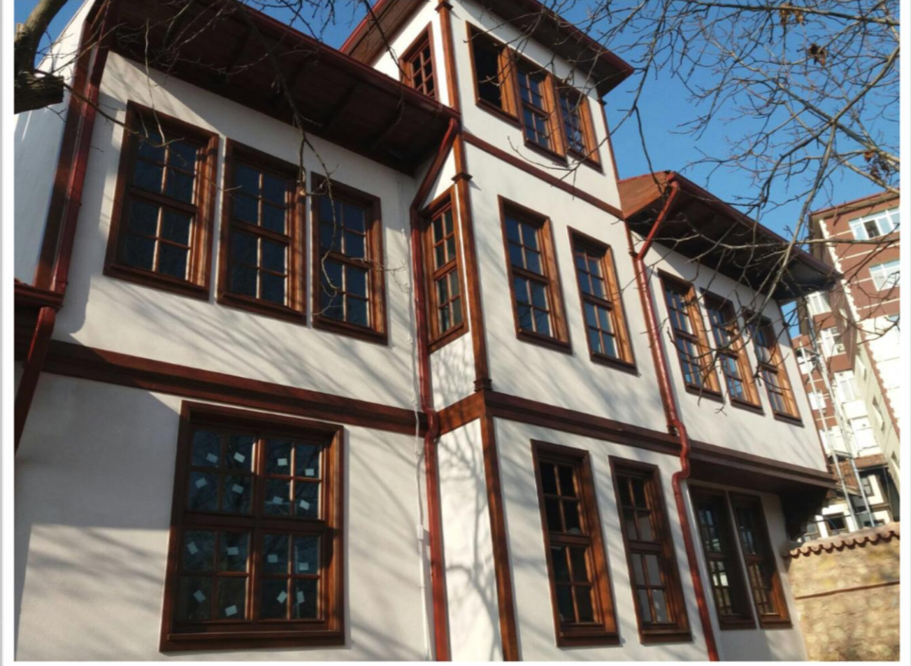
Resim 28: Yücebıyıklar Konağı Restorasyonu
